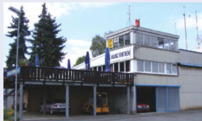
Der Sanierung des Towers steht nichts mehr im Weg
