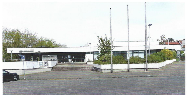
Das neue Bürgerhaus wird am Standort des alten gebaut.
